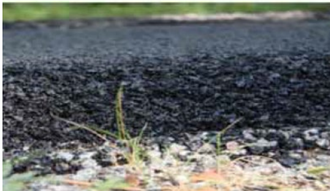
Stötdämpande asfalt RISE / PEAB
